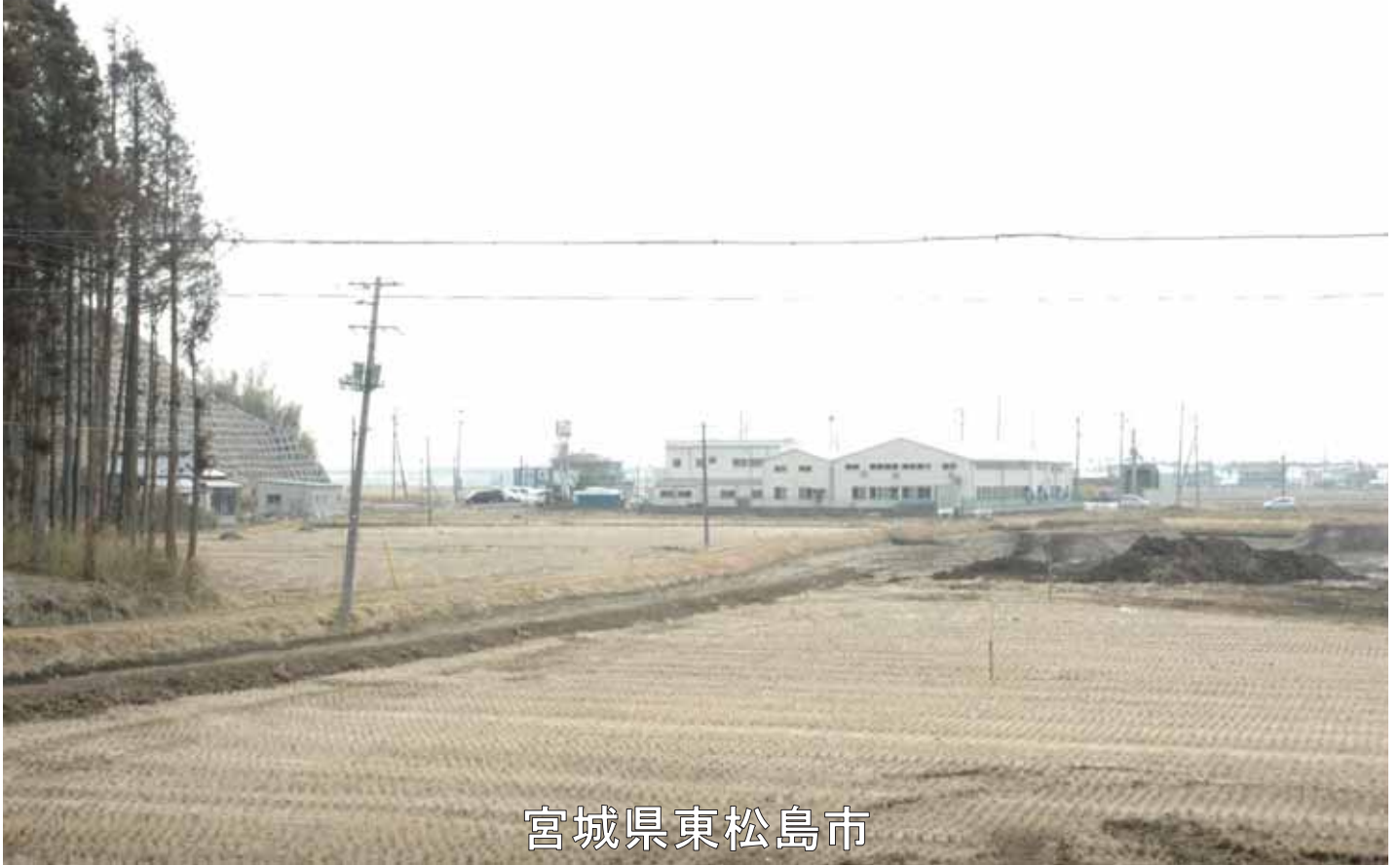
1210_5_018_023447_東松島市(広報)_2013.3.7_牛網団地_集団移転先造成状況
